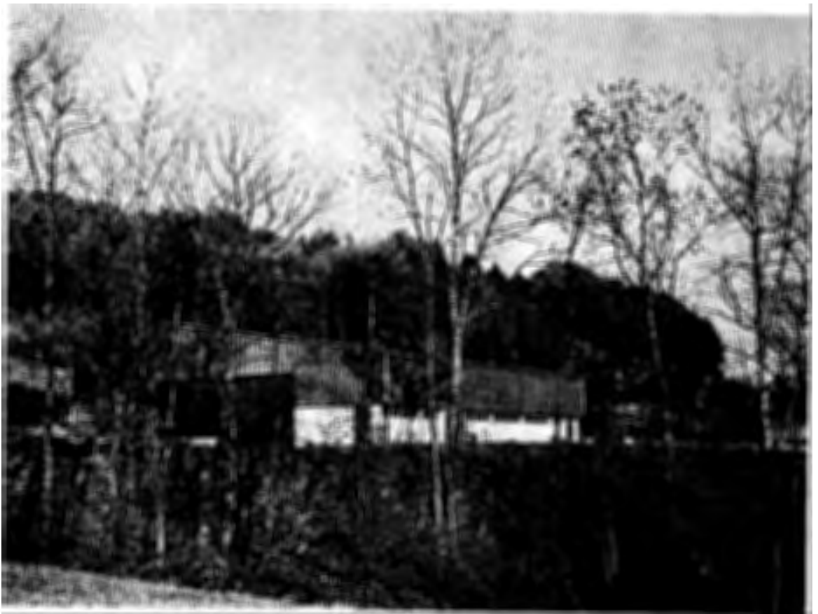
Hof in Wetswil, Schweiz. Hier wurde eine einheitliche Gestaltung von Wohn- und Oekonomiegebäuden angestrebt. (Projekt und Foto: SVIL, Zürich).
